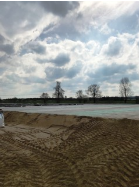
Hier soll der Schlamm aus dem Michlenzteich bei Altdöbern entwässern
